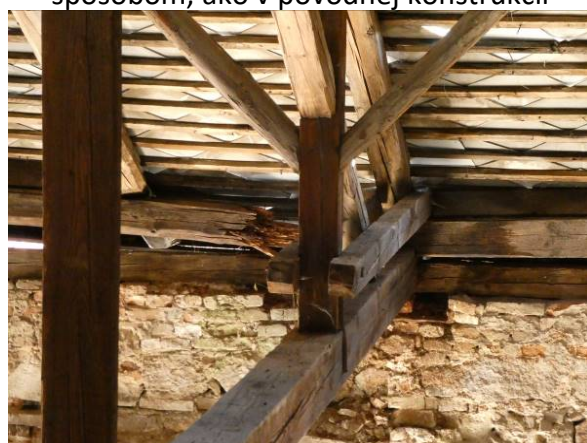
Obr. 35 – Totálna hniloba pozdĺžnika
