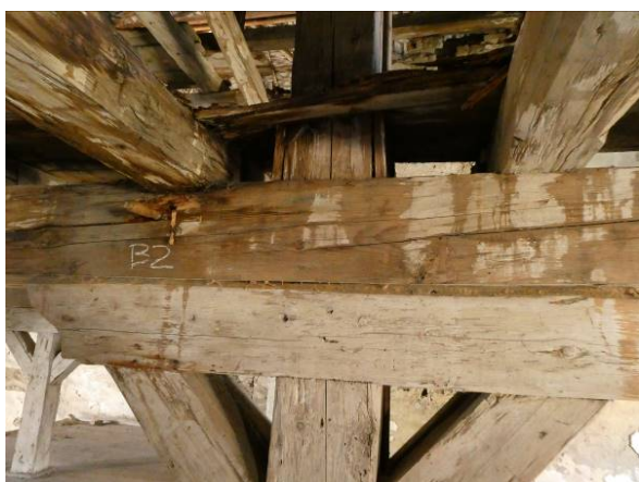
Obr. 20 – Totálna hniloba prievlaku B2, +5,250m
