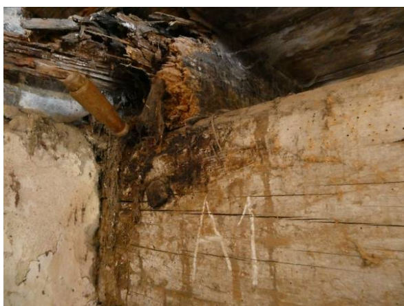
Obr. 14 – Totálna hniloba zhlavja prievlaku A1, +2,800m
