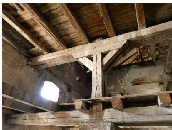
Obr. 17 – Chýbajúce SN medzi osami 3 a 4, +2,800m
