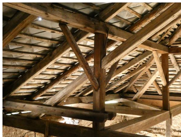
Obr. 39 – Podopretie VT nevhodnými stĺpmi na nevhodnom mieste
