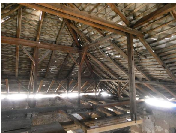
Obr. 34 – Prelomený VT v osi V2, väzba je nefunkčná
