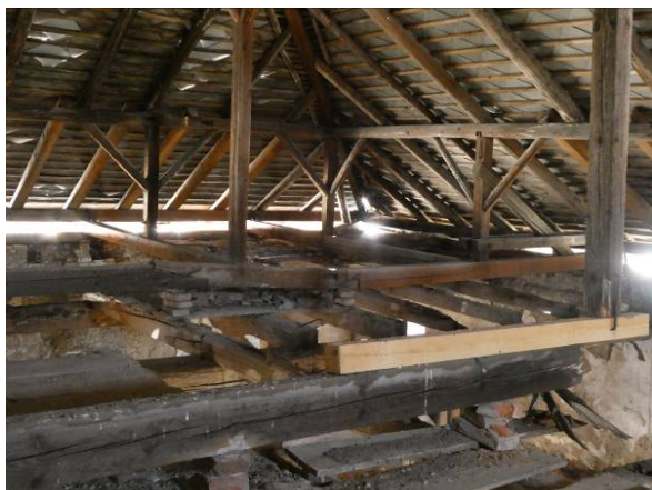
Obr. 36 – Prerušený VT, podopretie VT nie je správne, stĺp väzby je podopretý na labilnej sústave
