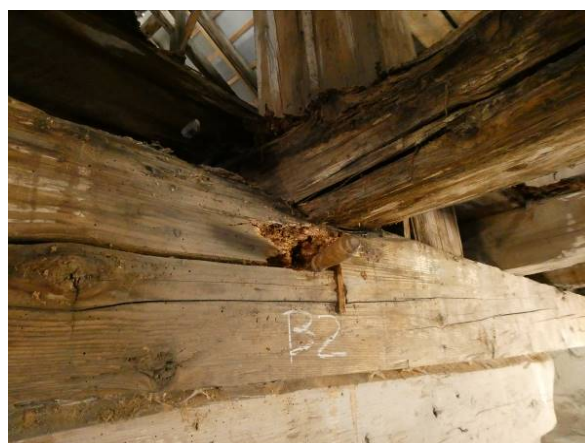
Obr. 21 - Totálna hniloba prievlaku B2, +5,250m - detail
