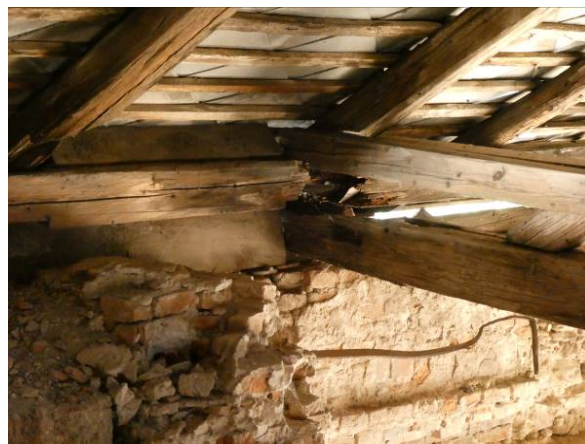
Obr. 41 – Totálne hniloba pozdĺžnika a zhlavia VT
