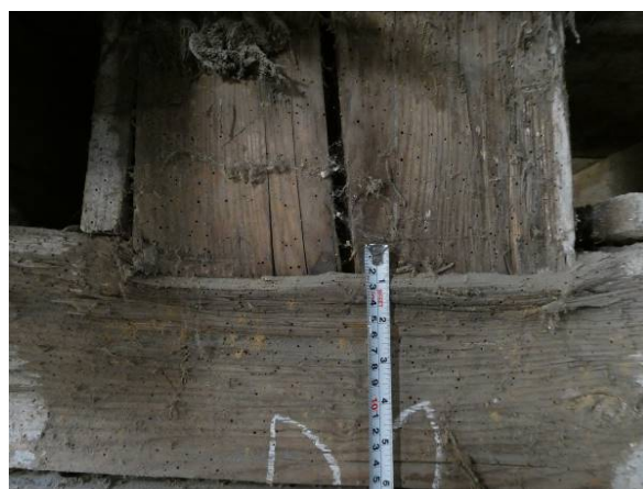
Obr. 9 – Črvotoč a zatlačenie prievlaku D2, +2,800m - detail
