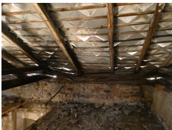
Obr. 40 – Prelomený pozdĺžnik medzi V3 a V4, totálna hniloba pozdĺžnika
