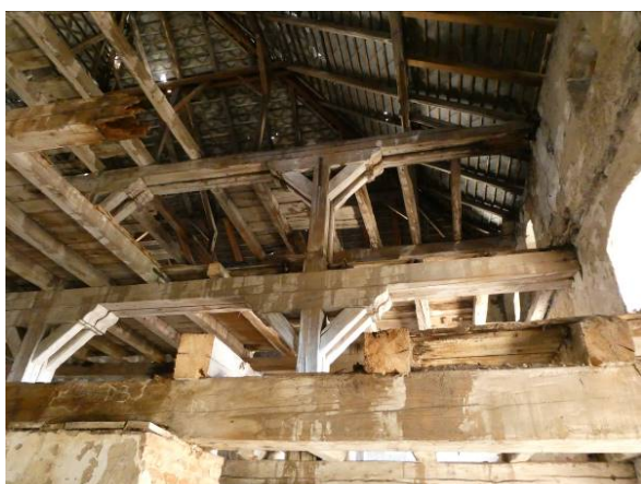
Obr. 16 – Chýbajúce SN medzi osami 3 a 4, +2,800m
