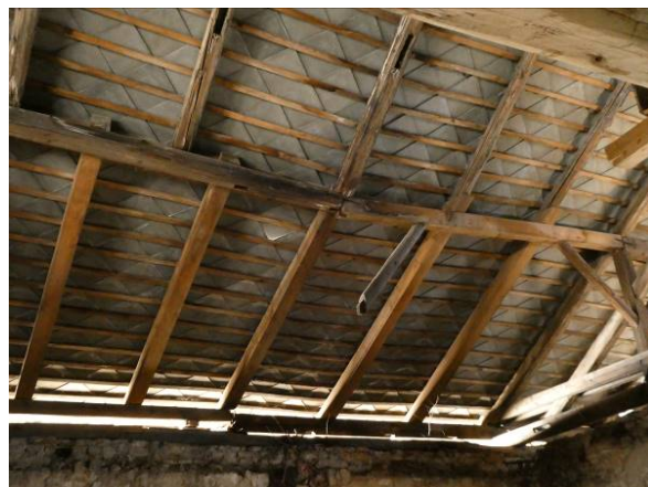
Obr.31 – Časť strechy môže náhle spadnúť, životu nebezpečné! Väzba V2 – osi D až E
