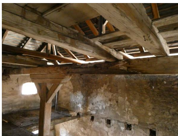
Obr. 27– Hniloba prievalu v osi 1, +7,700m
