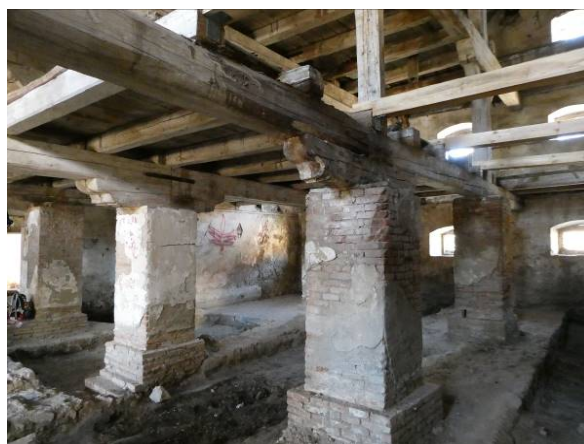
Obr. 5 – Pohľad na murované stĺpy a strop 1.N.P.
