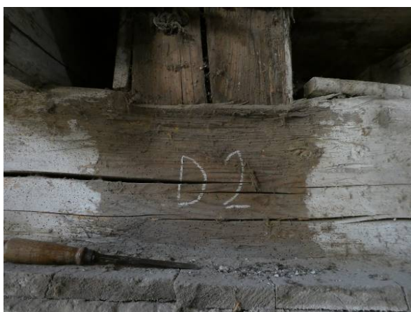
Obr. 8 – Črvotoč a zatlačenie prievlaku D2, +2,800m
