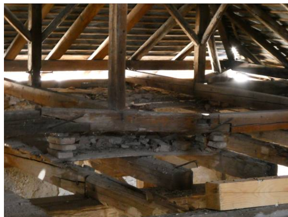
Obr. 37 – Prelomenie VT v osi V1 a výrazná deformácia väzby
