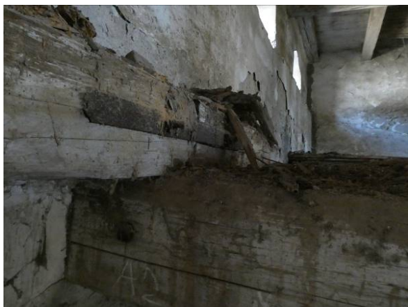
Obr. 6 – Totálna hniloba SN A2, +2,800m
