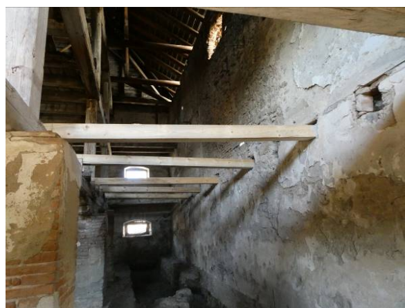
Obr. 15 – Dočasné stuženie steny a stropu, +2,800m
