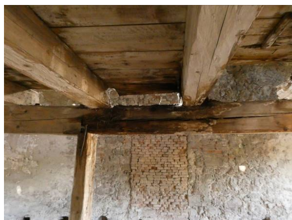
Obr. 23 – Chýbajúci stĺp a hniloba prievlaku pri C1, +5,250m
