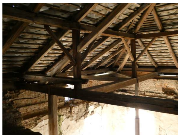
Obr.33 – Podopretie VT dočasnými a nedostatočnými podperami, zmenený statický systém krovu, VT sú namáhané iným spôsobom, ako v pôvodnej konštrukcii
