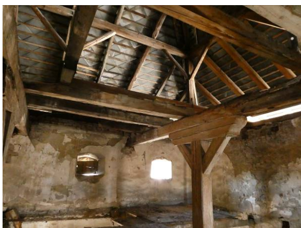
Obr. 26 – Hniloba SN a prievalu medzi B1 a C1, +7,700m
