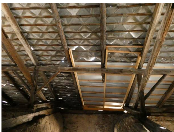
Obr. 32 – Dočasná sanácia, krokvy chýbajú alebo sú napadnuté hnilobou, neoriginálne prvky, väzný trám má poškodenie H3-H4
