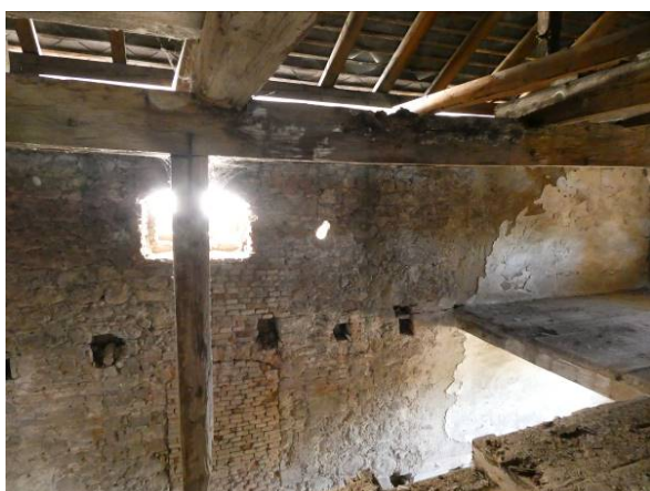
Obr. 28 – Náhradný nedostatočný stĺp v osi 1, +7,700m
