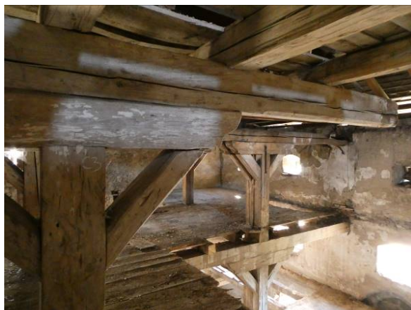
Obr. 25 – Chýbajúci prievlak za osou C3, +7,700m
