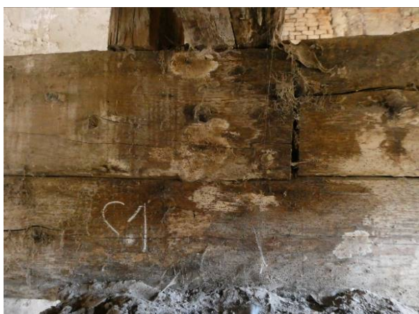
Obr. 10 – Črvotoč v prievlaku C1, +2,800m
