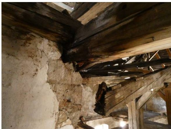
Obr. 24 – Totálna hniloba medzi B3-C3, +7,700m
