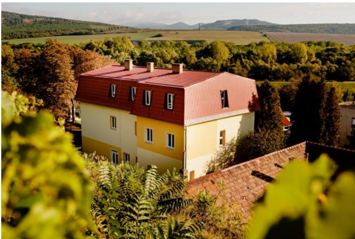
Prebieha rekonštrukcia za účelom vybudovania Centra Burda
