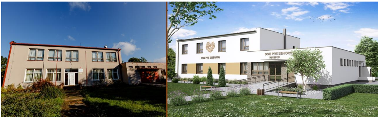
Dom seniorov v Salke (vo výstavbe)
